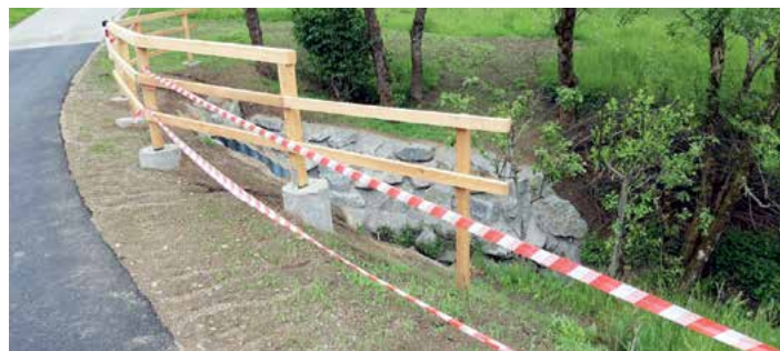
Brückensanierung Vorderwinkl Hoiskeusche
